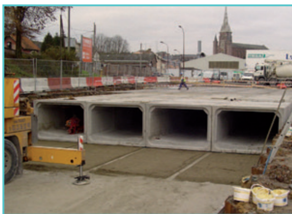
Conduite surdimensionnée. Porosité : 100 %
