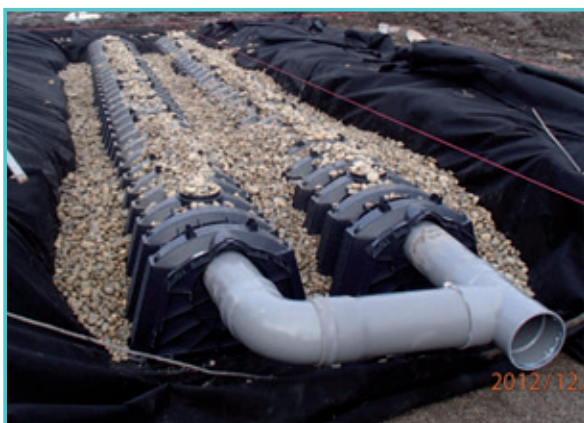
Structure tunnel. Porosité environ 70 %
