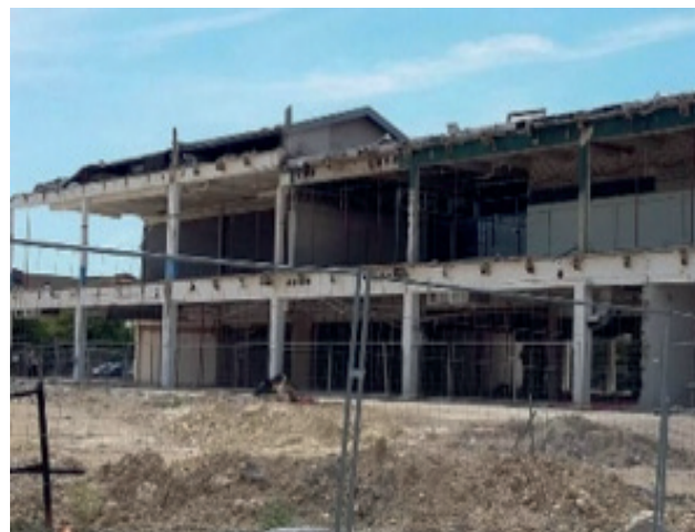
construction d'un centre commercial
