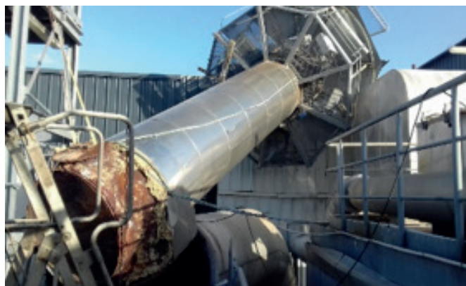
chute de la cheminée de l'incinérateur de Brive
