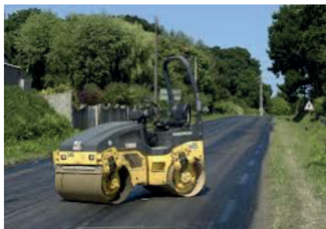
travaux de réfection routière
